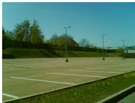
Odvodnění rozsáhlé zpevněné plochy u nákupního centra.
