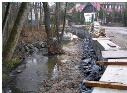
Zpevňování břehu na Botiči v Hostivaři v místech, kde potok začal ohrožovat příjezdovou komunikaci. Zdroj: Vlastní
