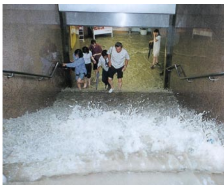
Podzemní nákupní centrum ve Fukuoce, Japonsko, zatopené přívalovým deštěm v roce 1999. Zdroj: Japan Sewage Works Association
