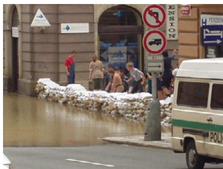
Při povodni v roce 2002 došlo i na výstavbu protipovodňových zátarasů – ve Zborovské ulici se stavěly z pytlů s pískem. Zdroj: Zdeněk Chytrý
