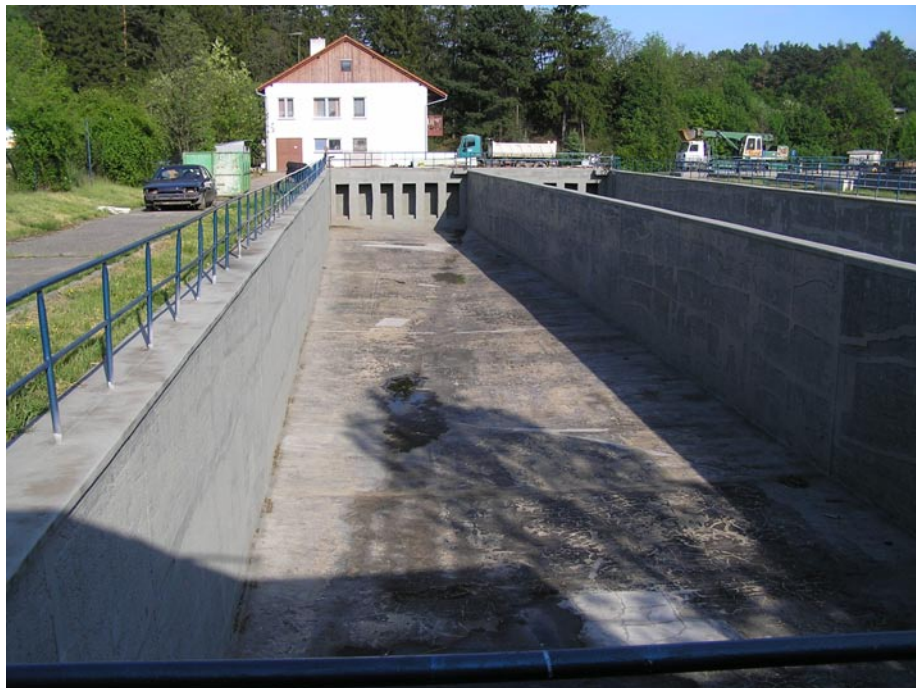
Retenční nádrž Řepy I bez hladiny stálého nadržení se svislými betonovými zdmi. Zdroj: Vlastní
