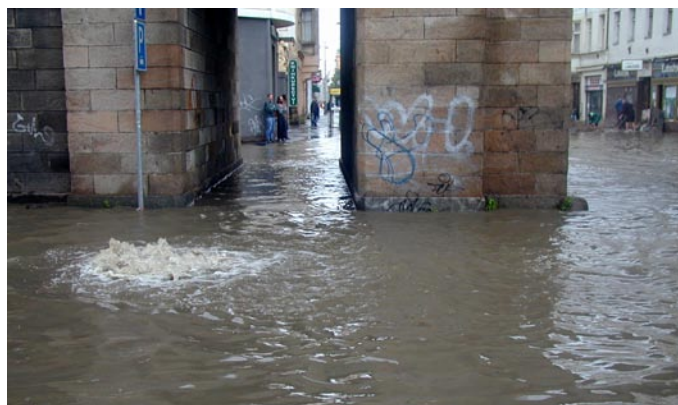
Výron vody z Vltavy kanalizační sítí při povodni v roce 2002 v ulici Sokolovská, Praha-Karlín. Zpětné vzdutí způsobuje záplavu intravilánu, který v daném okamžiku není přímo ohrožen povodňovým stavem v toku. Zdroj: Archiv PVS, a. s.
