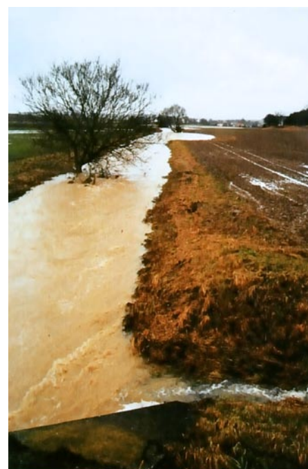
Tento potok byl zregulován (jako i řada dalších) v důsledku scelování polí v 50. a 60. letech 20. století. I při vysokém průtoku vody nevystupuje z břehů a odvádí vodu velkou rychlostí ihned do nejbližší řeky, jež tak dosahuje během krátké doby vysokých odtokových maxim. Zdroj: Spektrum Wasser 1, 2004
