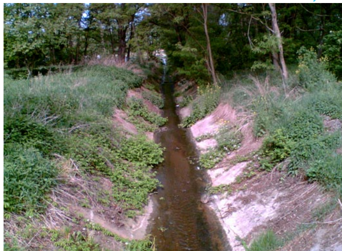
Regulace Cholupického potoka betonovým opevněním. Zdroj: Vlastní
