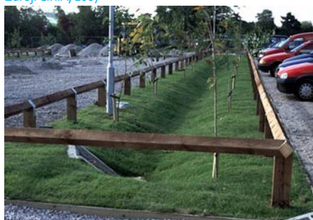
Opatření u zdroje – retenční a infiltrační mulda na velkokapacitním parkovišti. Zdroj: CIRIA, 2007
