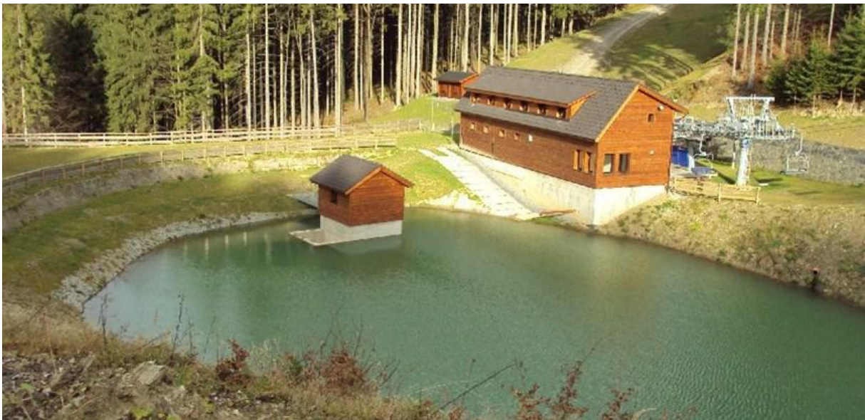
Obr. 32 Ukázka vybudované retenční nádrže pro Ski centrum Kohútka Zdroj: Enviweb (2011)
