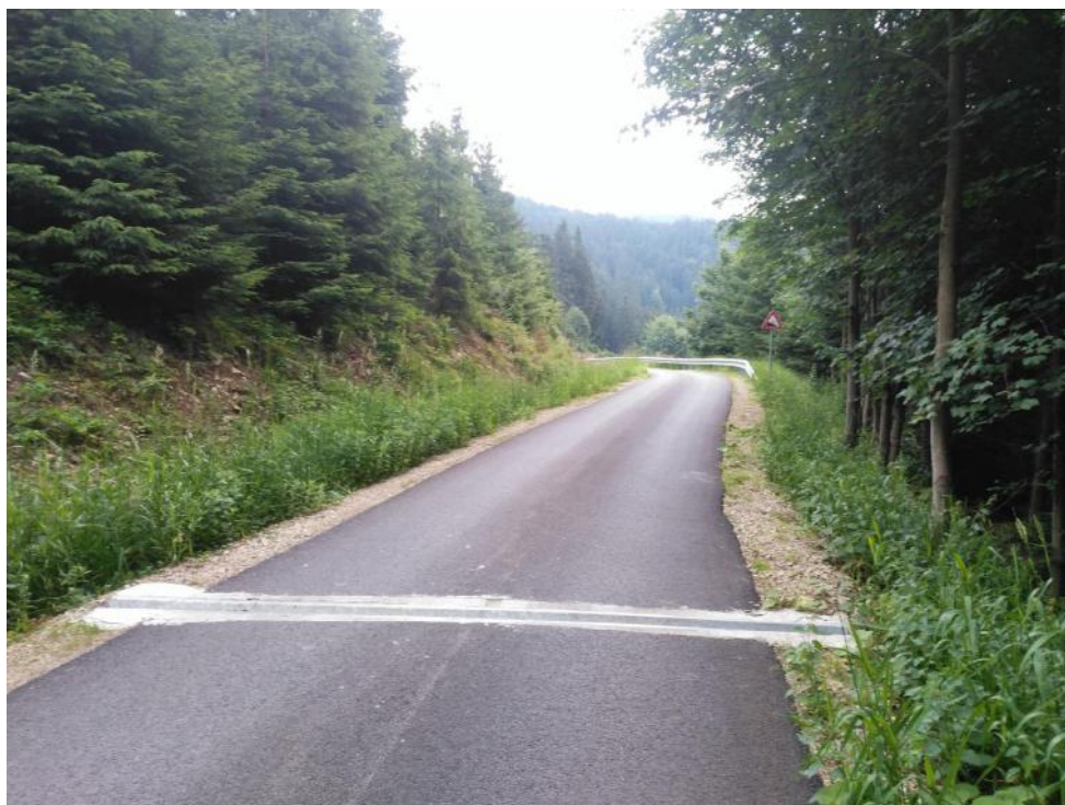
Obr. 17 Příklad odvodňovací odrážky na lesní cestě nad obcí Štiavnik, pohoří Javorníky, CHKO Kysuce. Zdroj: Barka (2018)
